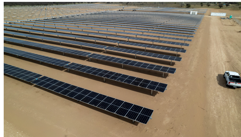
Imagen del Parque Solar Fotovoltaico Victorica (7,2 Mw)
